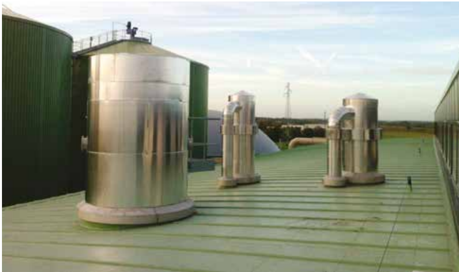
Installation de traitement de digestat de de Tiper Méthanisation (Thouars, 79), en service depuis 2013.
