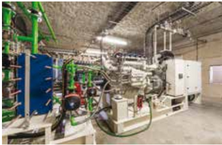
Module de cogénération Biogaz_ Terragen191
