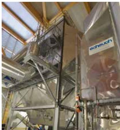
Electrofiltre et condenseur
